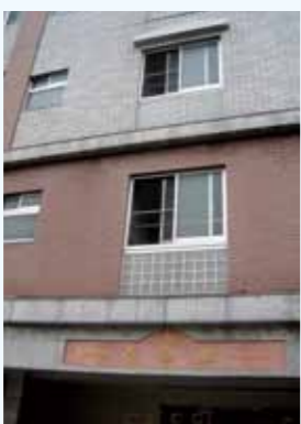
以前は木造の古い簡宿が多かったが、今はビルが増えてきた
